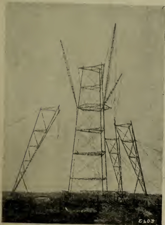
ASSEMBLING A PYLON.
